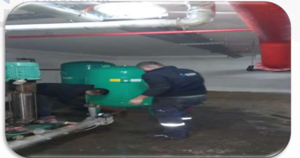
Hidrofor sistemi genleşme tankı mebran değişimi gerçekleştirilmiştir.
