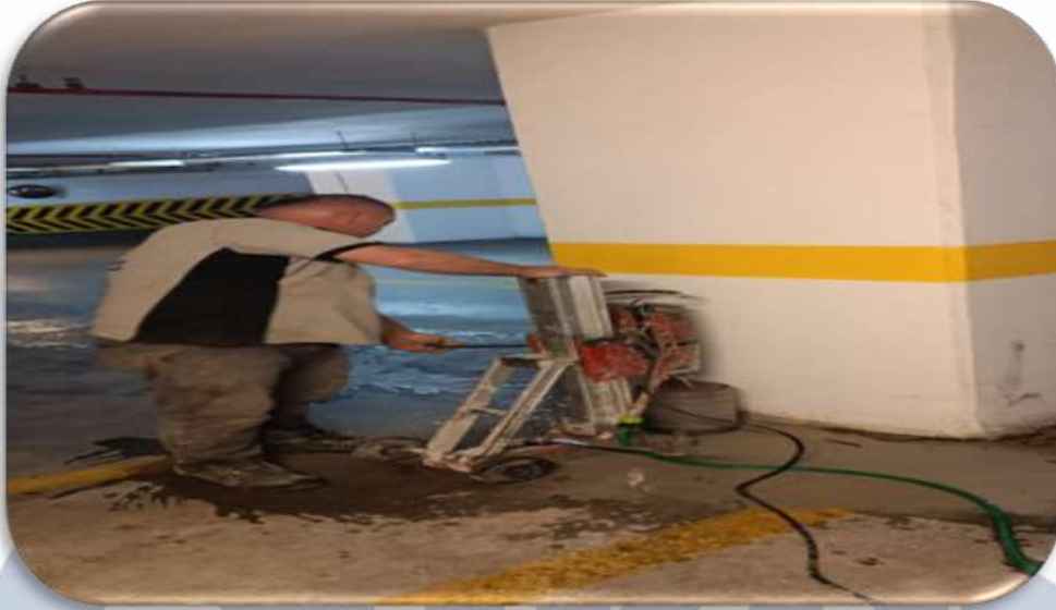
- 4 hidrofor odasına karot ile havalandırma deliği açılmış ve havalandırma borusu takılmıştır.
