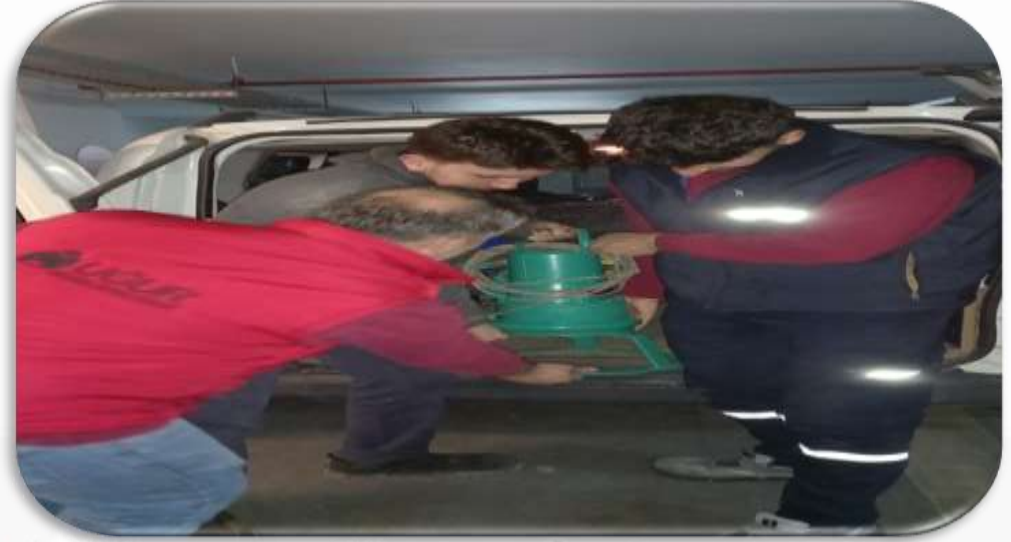
-4 kuyu yağmur suyu dalgıç pompasının tamiri sonrasında kontrolleri sağlanmış ve montajı gerçekleştirilmiştir.
