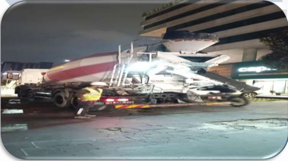
Açık otopark zemin boşluklarına beton uygulaması gerçekleştirilmiştir.
