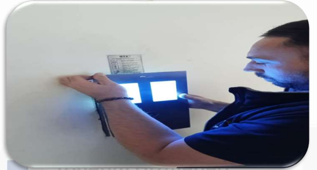
Arızalı asansör kat göstergelerinin kontrolleri sağlanmış ve arızalı olanlar yenileri ile değiştirilmiştir.
