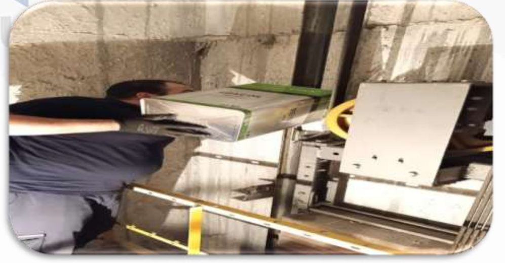
Asansörlerin aylık bakım faaliyetleri gerçekleştirilmiştir.
