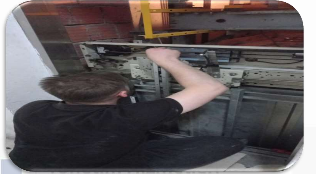
A Blok yük asansörü makas ve kaşık kontrolleri gerçekleştirilmiştir.
