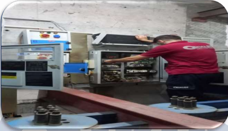
B Blok sađ asansör 2 adet akü deęişimi yapılmıřtır.
