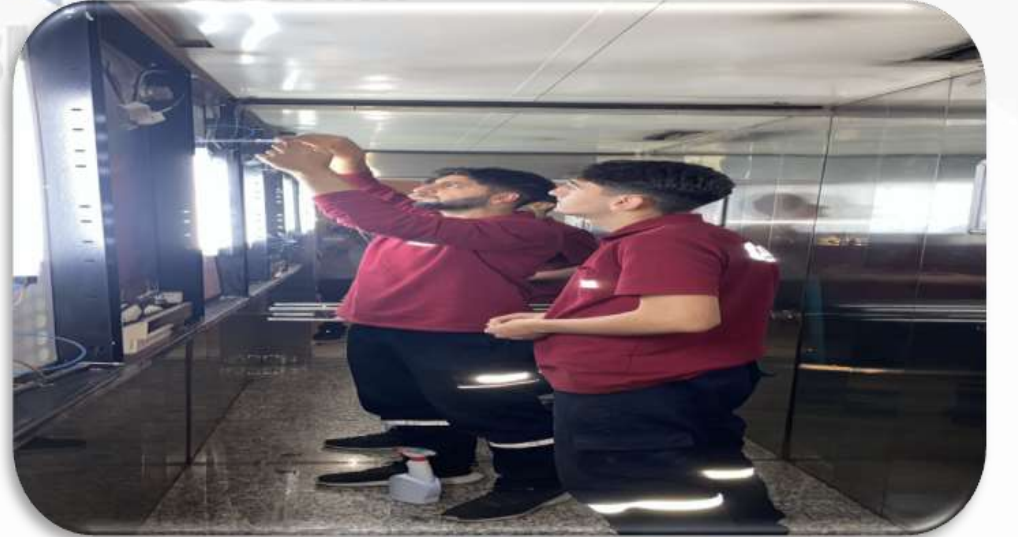
Asansör kabin ii aydınlatmaları yenilenmiřtir.
