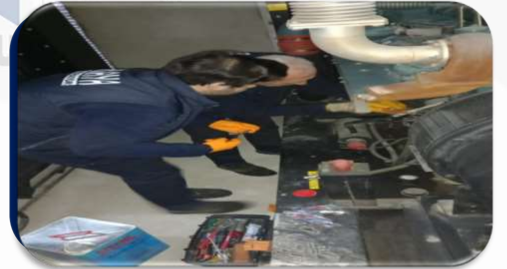
Jeneratörlerin su vanaları değiştirilmiştir.
