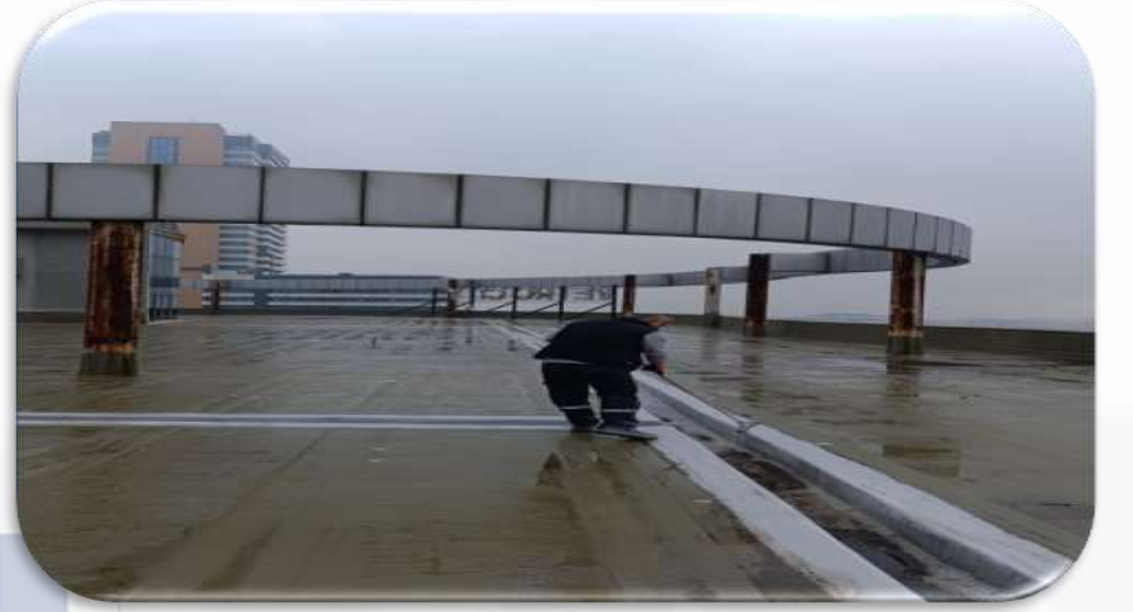
Çatıda lokal izolasyon çalışması gerçekleştirilmiştir.
