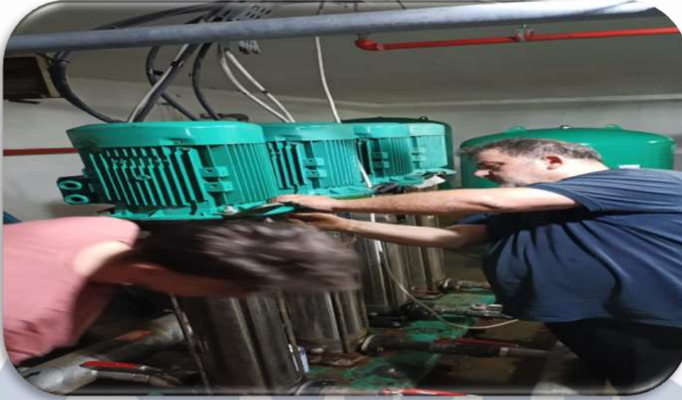
1 nolu Hidrofor arızaları giderilmiş, montajı yapılmıştır.
