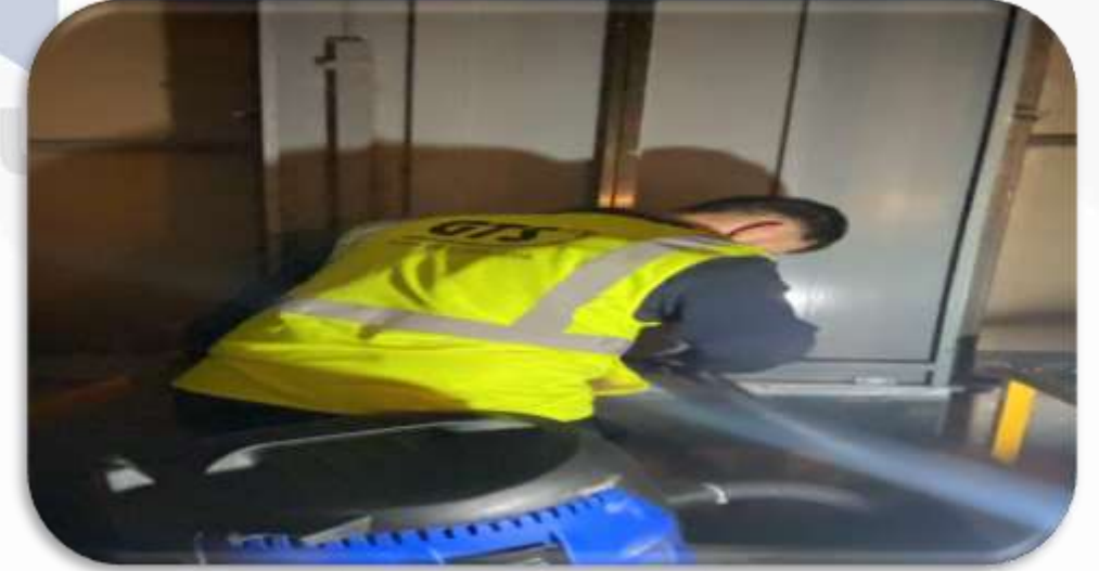
Asansörlerin aylık bakım faaliyetleri gerçekleştirilmiştir.
