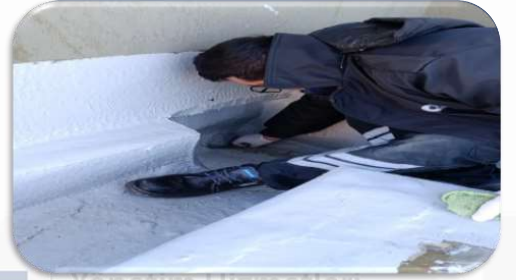
Çatı izolasyon kontrolleri sağlanmıştır.
