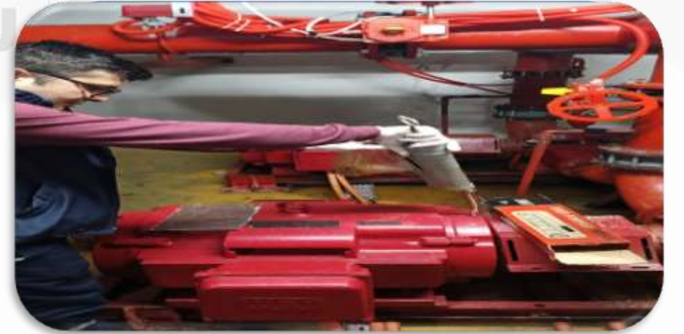
Hidrofor sistemi motorlarına yağ takviyesinde bulunulmuştur.
