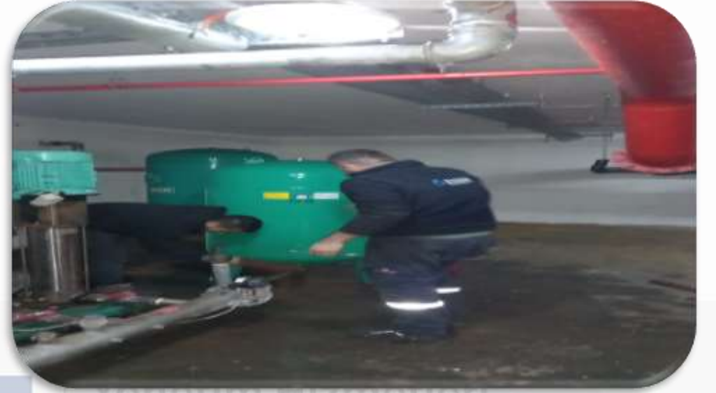
Hidrofor sistemi genleşme tankı mebran değişimi gerçekleştirilmiştir.
