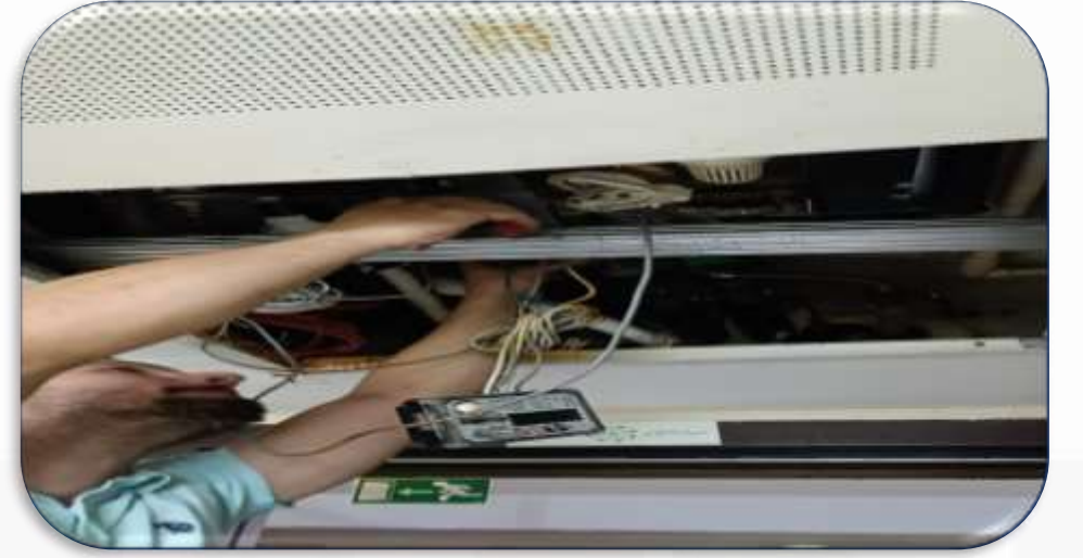
Isı sayaçları yasal muayene süreci tamamlanan ısı sayaçlarının montaj işlemleri devam etmektedir.
