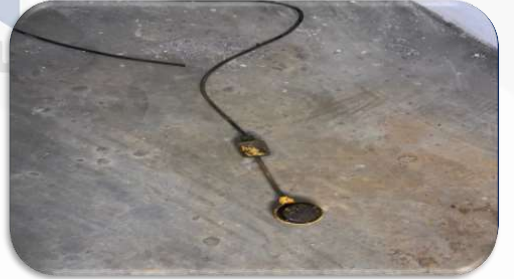
-4.Kat Drenaj hattı flatörü değiştirilmiştir.
