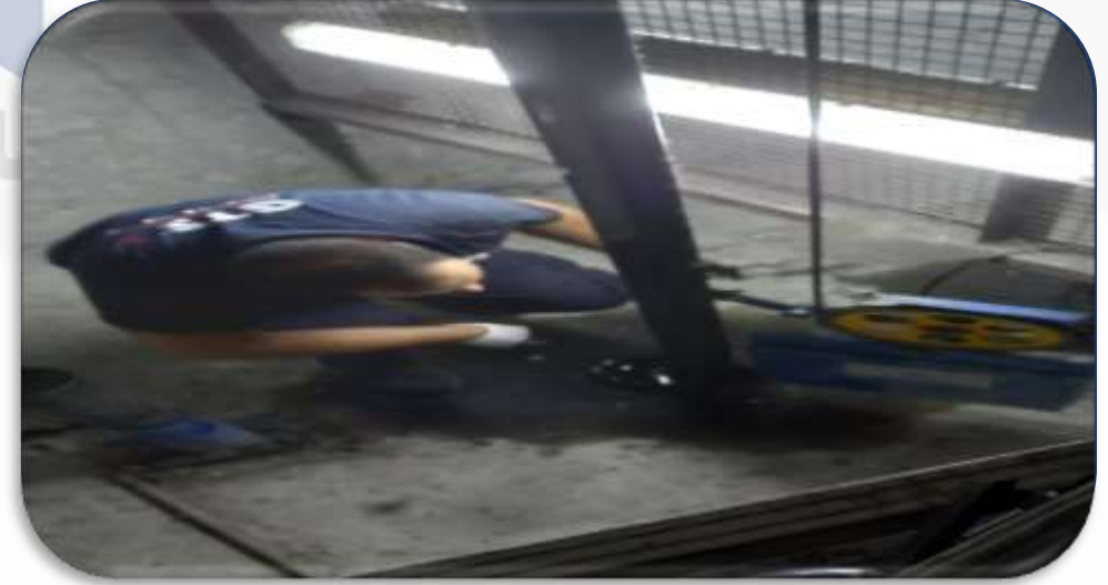
Asansörlerin aylık bakım faaliyetleri gerçekleştirilmiştir.
