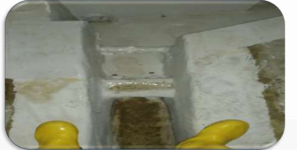
Çatı izolasyon onarımları tamamlanmış, su sızdırma test işlemleri devam etmektedir.
