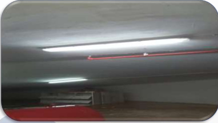
Ortak alandaki arızalı floresan ve led aydınlatmalar yenileri ile değiştirilmiştir.
