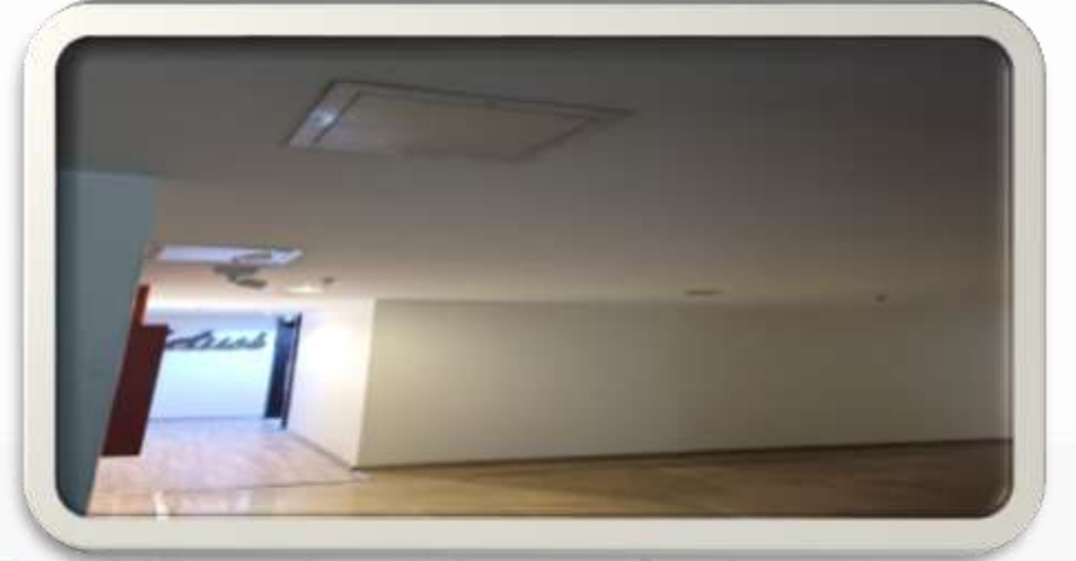
A Blok 1.Kat ortak alan alçıpan ve boya işleri tamamlanmıştır.
