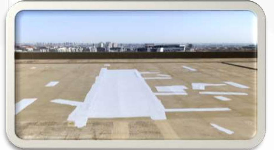
Çatı izolasyon onarımları tamamlanmıştır.
