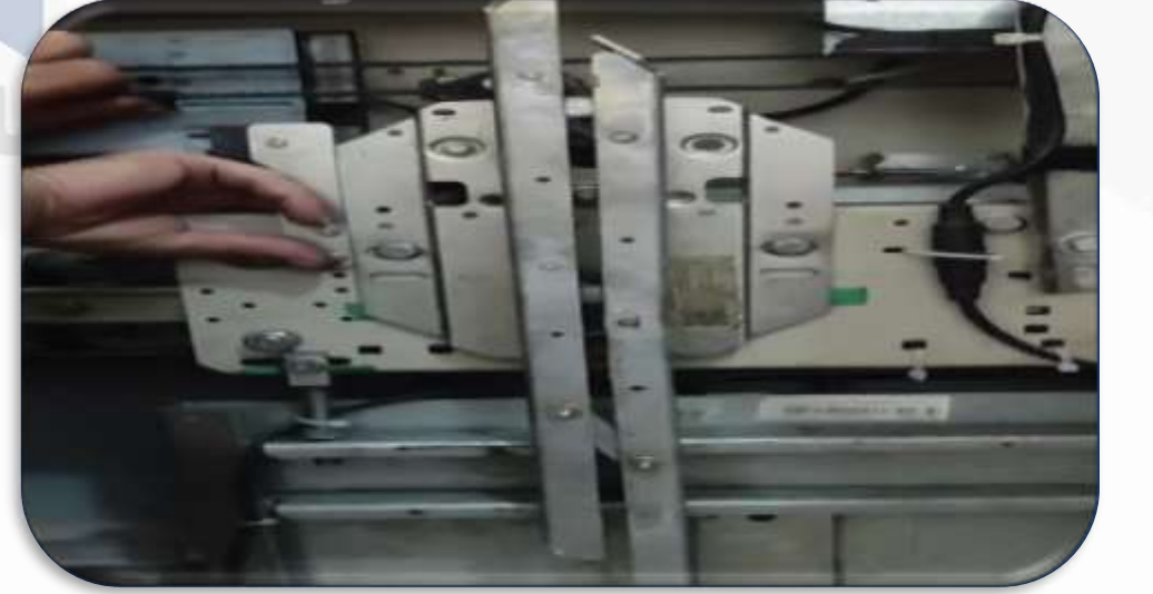
A blok yük asansörü makas değişimi yapılmıştır.
