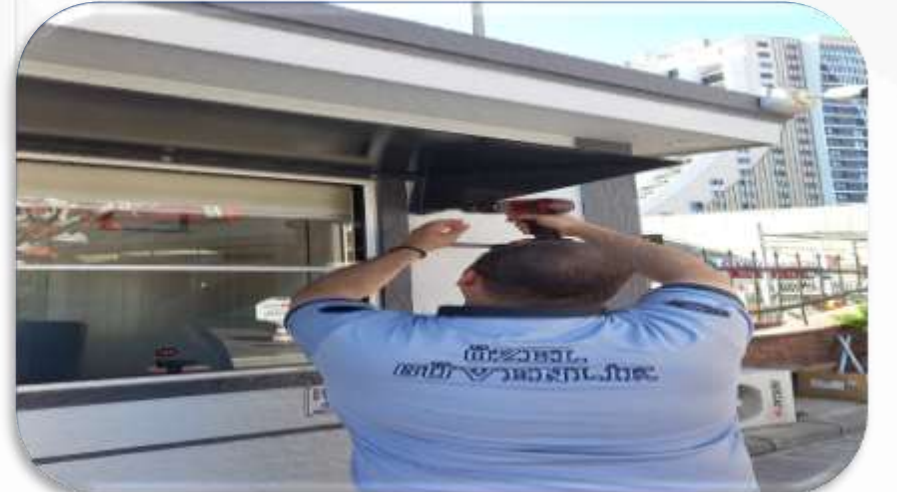
Güvenlik kulübesi güneşlik montajı yapılmıştır.
