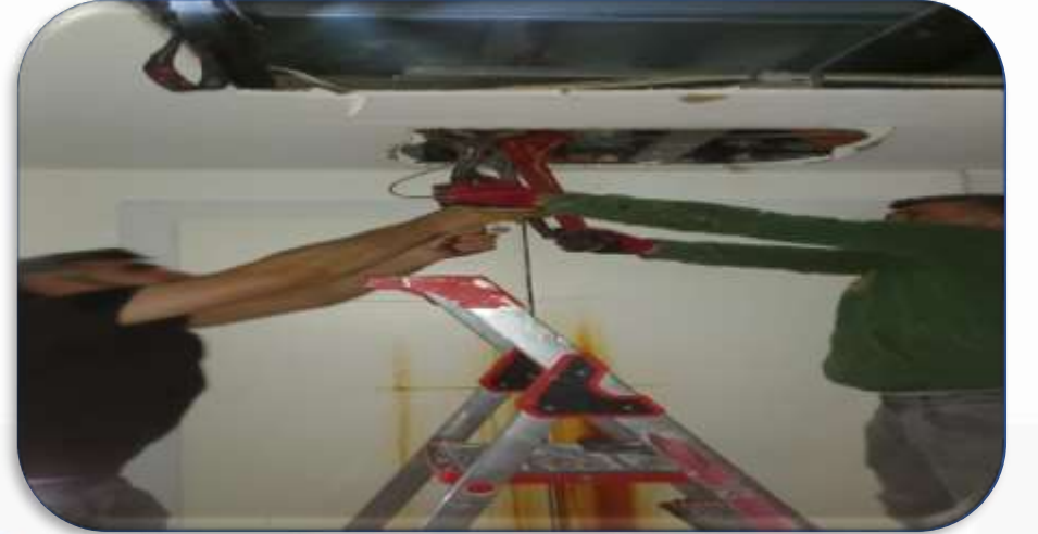
A Blok 1.Kat tesisat su kaçağı onarımı yapılmıştır.
