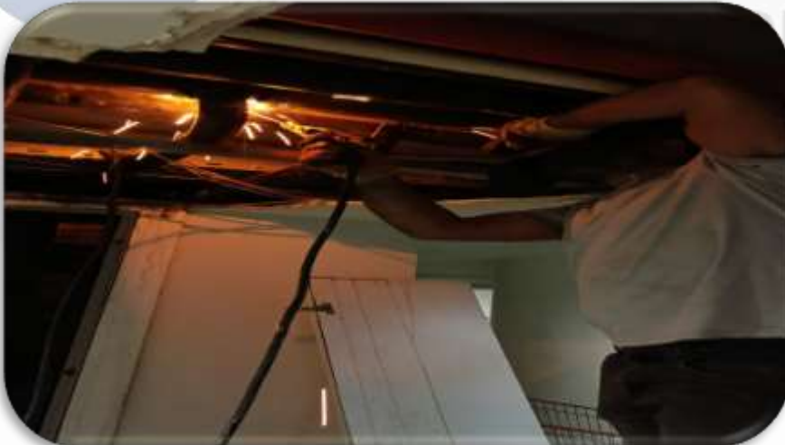
B Blok 4.Kat tesisat su kaçağı onarımı yapılmıştır.
