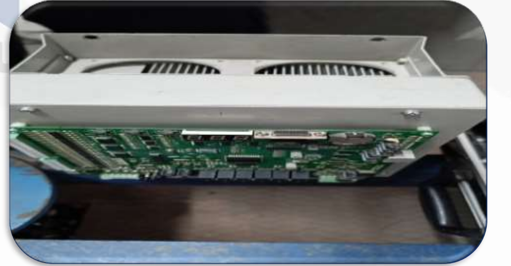
B Blok sağ asansör inverter fanları değiştirilmiştir.
