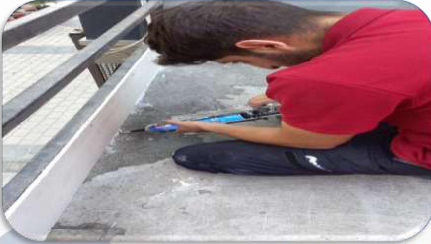
Otopark çıkışı kapı üstü, su sızıntısını önlemek amacıyla betopan ile kapatılmış, izolasyonu yapılmıştır.
