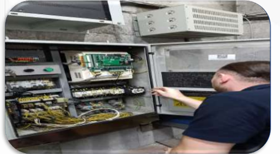
A blok sağ asansör kontaktörü yenisi ile değiştirilmiştir.
