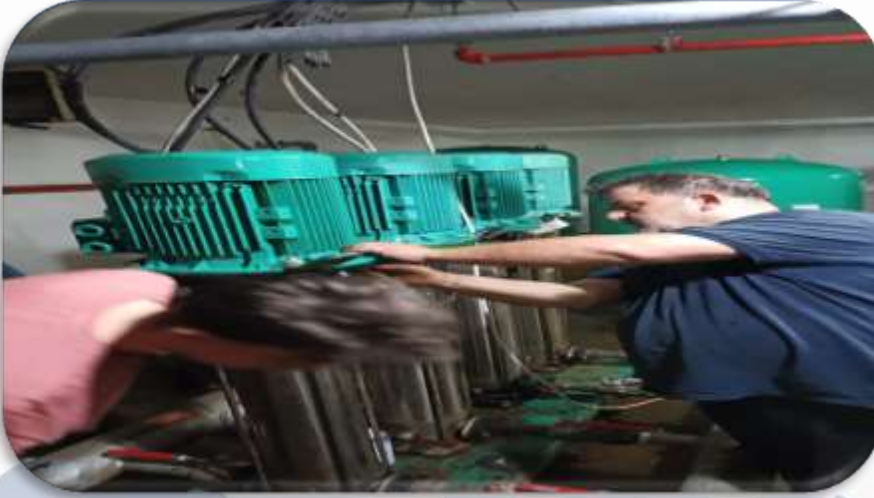
1 nolu Hidrofor arızası giderilmiş, montajı yapılmıştır.
