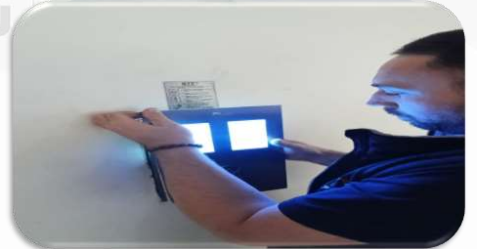
Arızalı asansör çağrı ekranları yenileri ile değiştirilmiştir.
