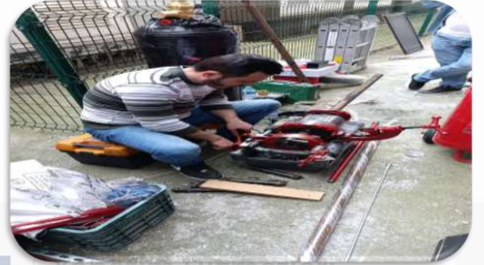
Elektrik ana dağıtım pano odası FM 200 otomatik yangın söndürme sistemi kurulumu tamamlanmıştır.
