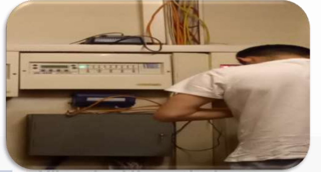
Yangın algılama sistemi kontrolleri gerekleřtirilmiřtir.
