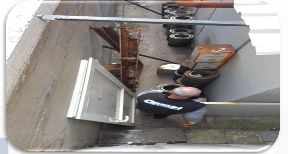
Jeneratör odasının temizliği gerçekleştirilmiştir.
