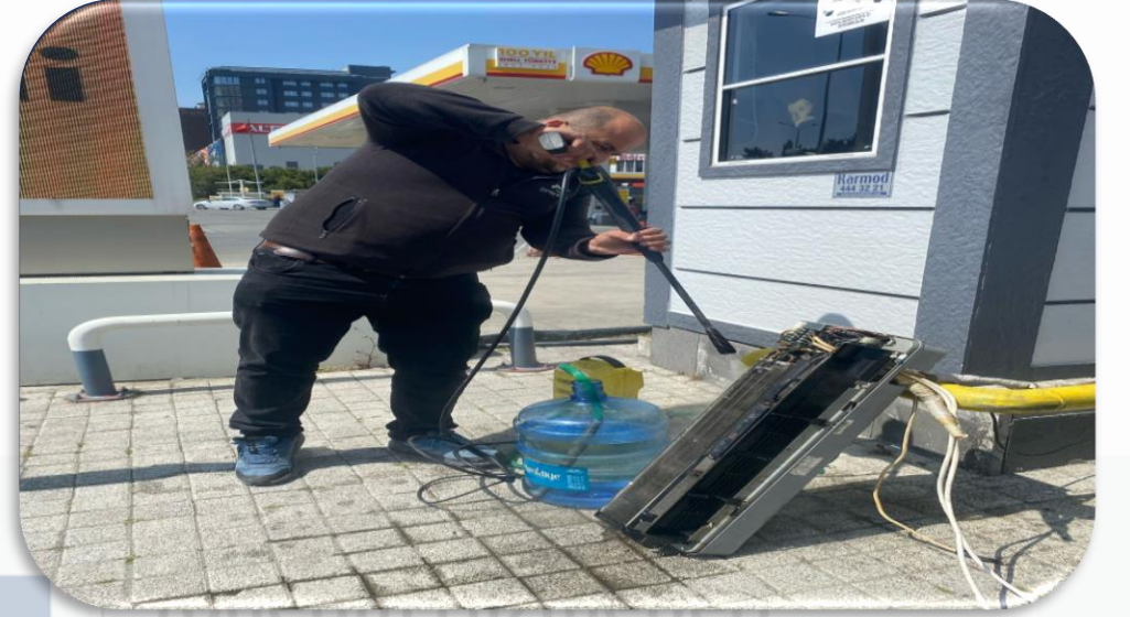
Güvenlik kabini ve teknik ofisteki klimaların periyodik bakımları gerçekleştirilmiştir.
