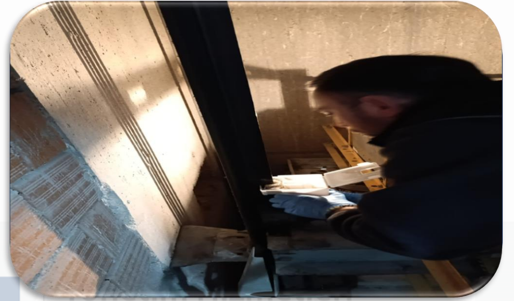
Asansörlerin yağdanlıkları yenileri ile değiştirilmiştir.
