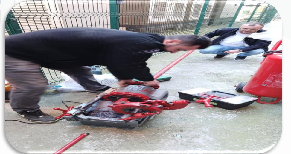
Elektrik ana dağıtım panosu yangın söndürme sistemi kurulumuna başlanılmıştır.
