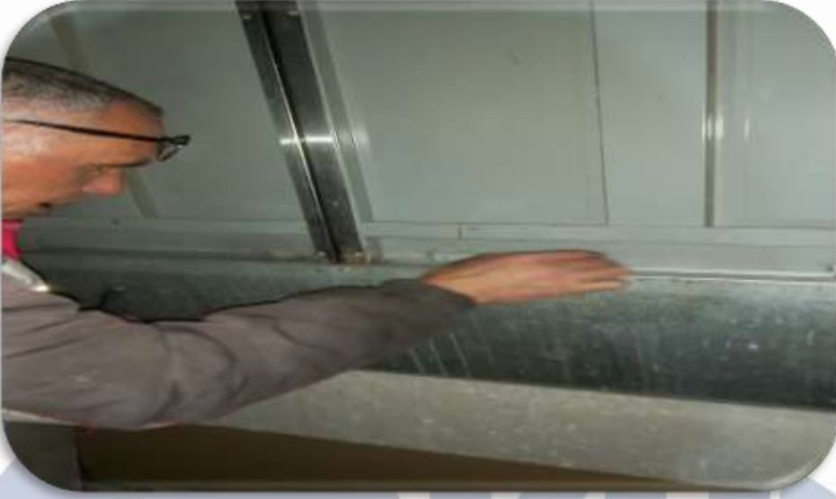
Asansörlerin aylık bakım faaliyeti gerçekleştirilmiştir.
