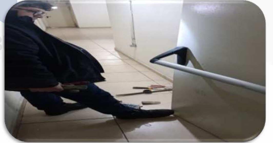
Bina geneli acil ıkıř kapılarının hasar kontrolleri gerekleřtirilmiřtir.
