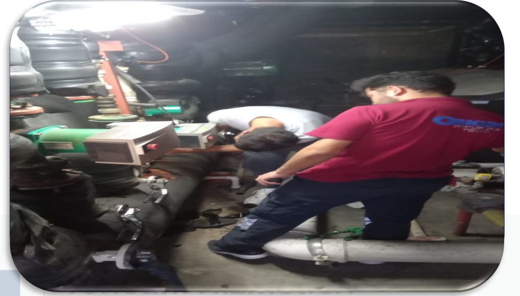
Isıtma sistemi vana arızası giderilmiştir.
