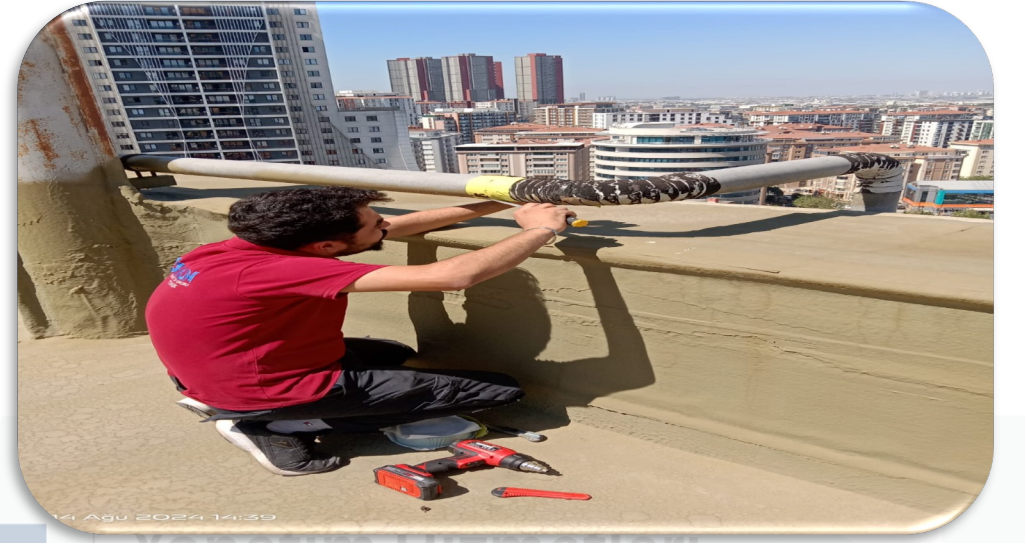
Doğalgaz borusunun sıcak sargı bandı yenilenmiştir.
