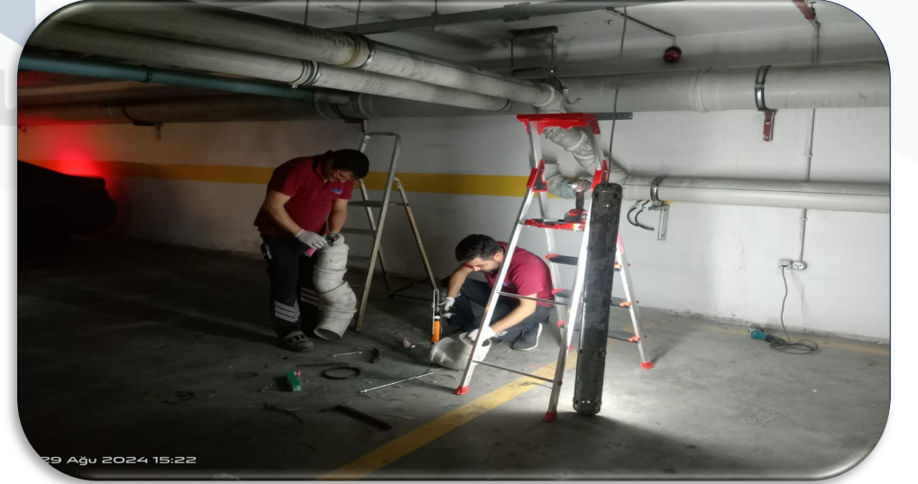
Yağmur suyu drenaj hattı giderleri güçlendirilmiştir.
