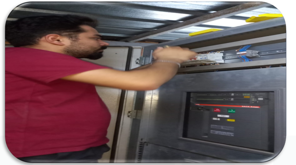
Elektrik trafosu A blok zaman rölesi yenisi ile değiştirilmiştir.
