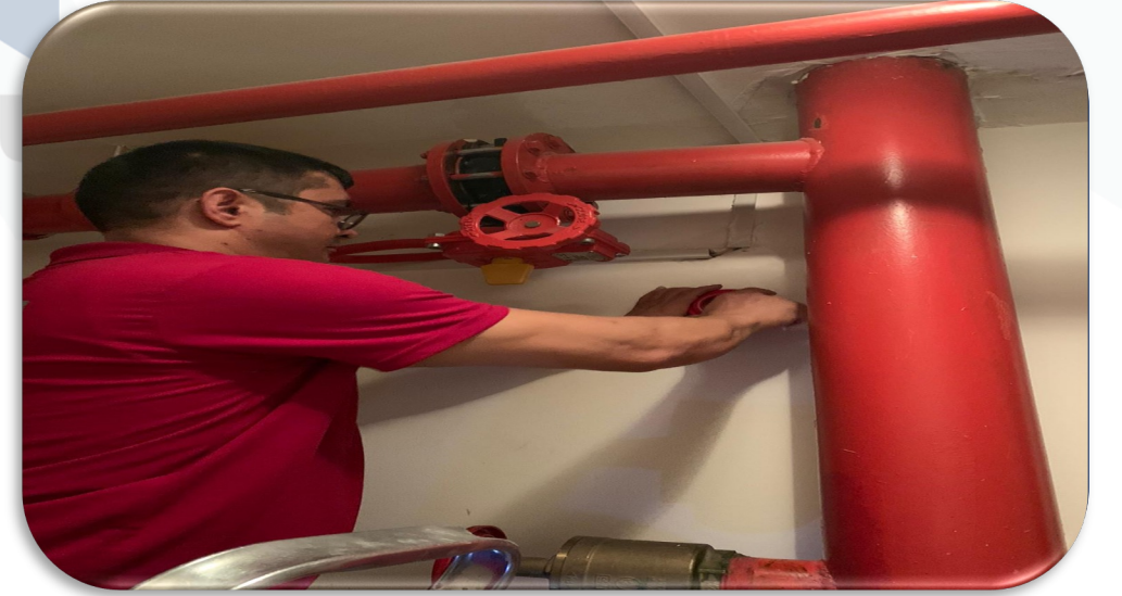
Yangın alarm sistemi kontrolleri gerçekleştirilmiştir.
