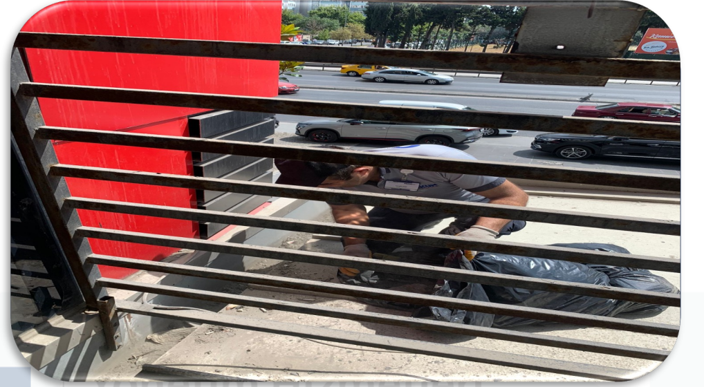
Blok giriş sundurmalarının detaylı temizliği gerçekleştirilmiştir.
