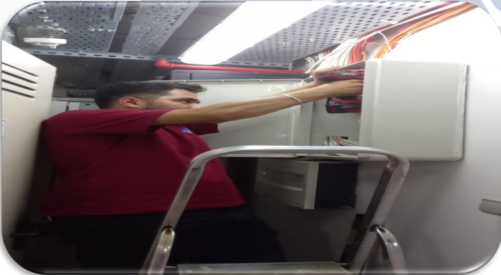
A Blok 9. kat elektrik odasının pano montajı gerçekleştirilmiştir.
