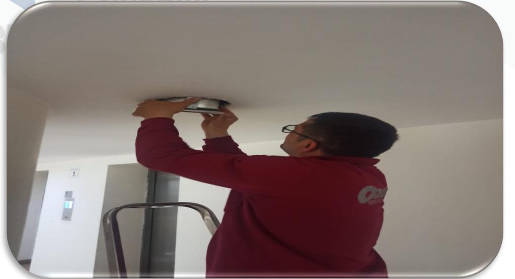
Bina geneli aydınlatma arızalarının kontrolleri gerçekleştirilmiştir.
