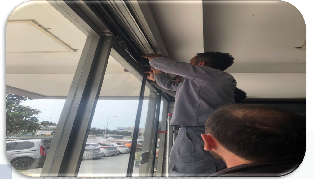
Bina giriş kapılarının periyodik bakımları gerçekleştirilmiştir.
