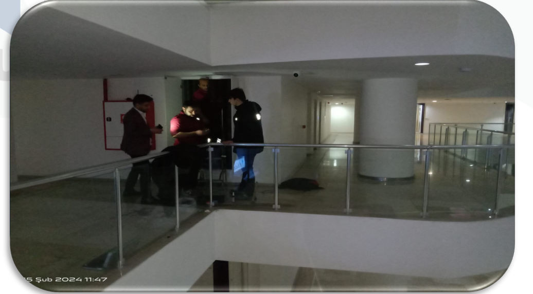
Isıtma sistemi sıcak su dnüş hattı kaaklarında keŒif alıŒmaları yrtlmŒtir.
