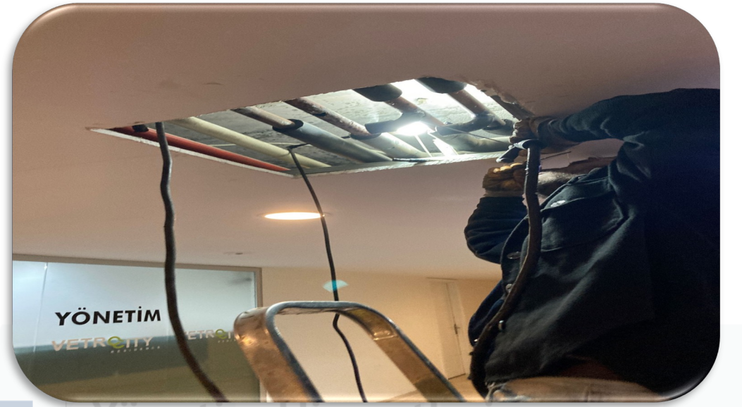
Yönetim ofisi için iklimlendirme bransman hattı çekilmiştir.
