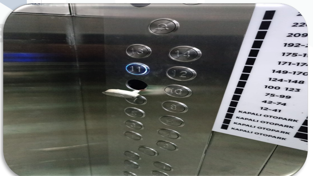
Asansörlerin kabin içi hasar kontrolleri gerçekleştirilmiştir.
