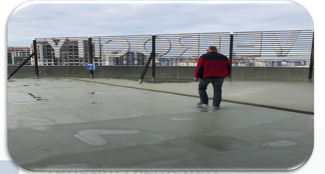
Çatı zemin izolasyon uygulamasının detaylı kontrolleri gerçekleştirilmiştir.
