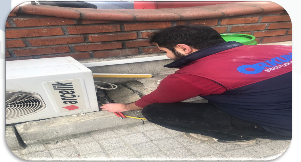
Güvenlik kabini klimasının gaz şarjı gerçekleştirilmiştir.
