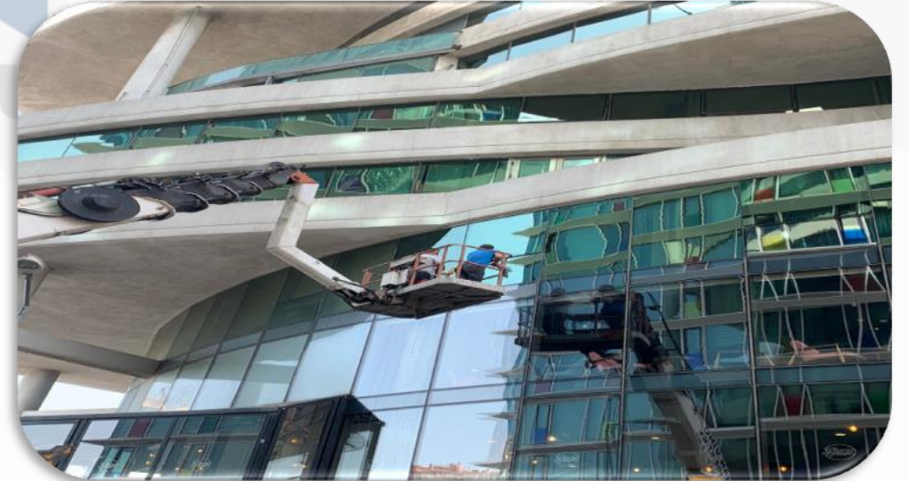
Binamızın dış cephe cam temizlik faaliyeti gerçekleştirilmiştir.
