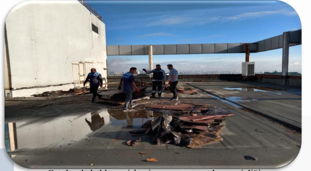
Çatı hurda kaldırma işlemi sonrası çatı moloz temizliği gerçekleştirilmiştir.
