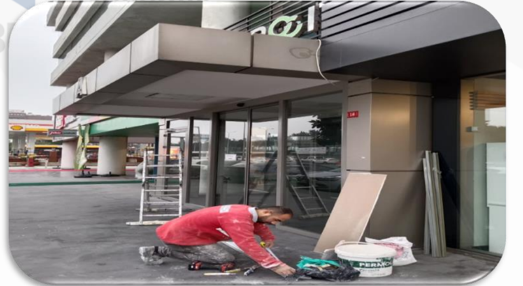
Bina giriş holü hava izolasyonu sağlanmıştır.
