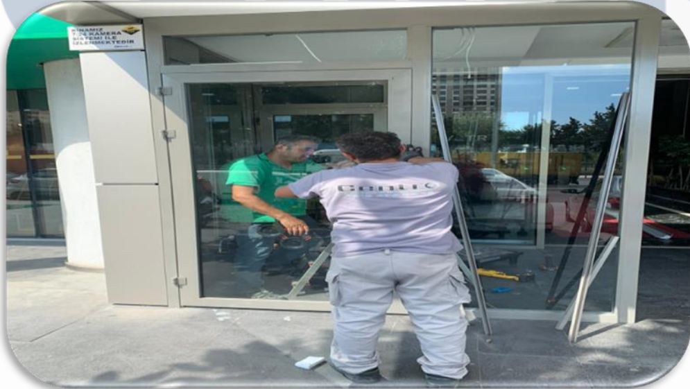
Lobilerin hava sıcaklık derecesini sabitlemek amacı ile blok girişlerine 2.fotoselli kapı montajı gerçekleştirilmiştir.
