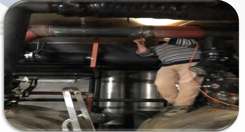
3-4 kat aralığındaki şaft su kaçağına teknik müdahalede bulunulmuştur.
