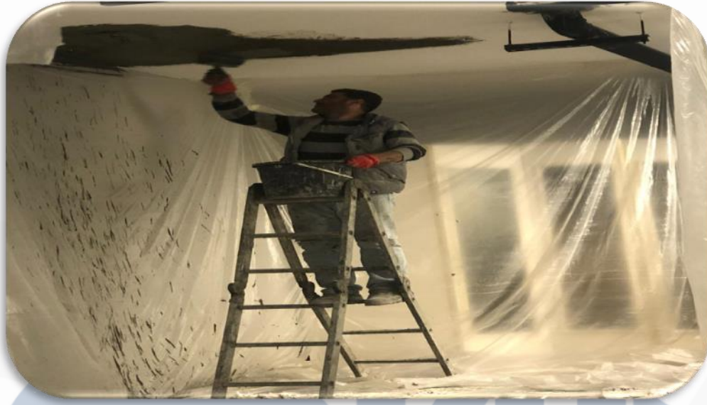
B Blok giriş alanı zemin altından izolasyon çalışması gerçekleştirilmiştir.
