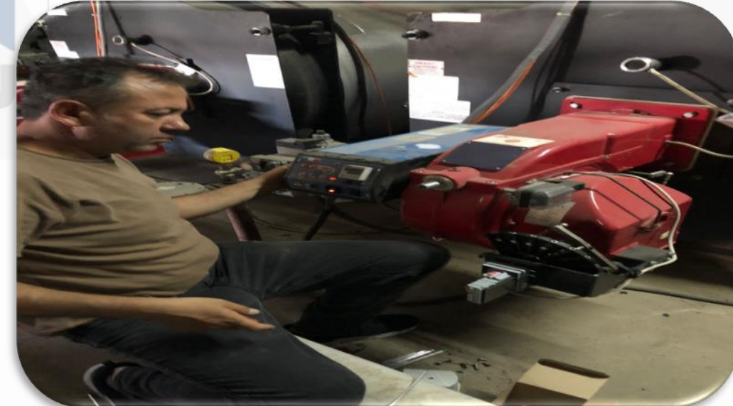
Isıtma sistemi 2 nolu kazanın arızalı servo motoru yenisi ile değiştirilmiştir.
