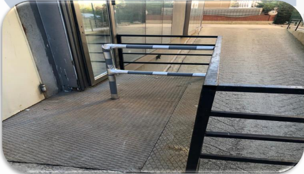
A Blok yük asansörü lobi kat çıkış alanına koruma bariyeri monte edilmiştir.
