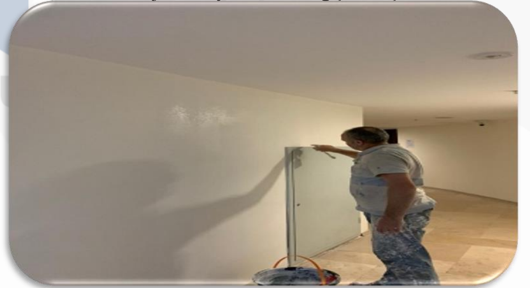
Ortak alanda değişen şaft kapaklarının çevresi boyanmıştır.
