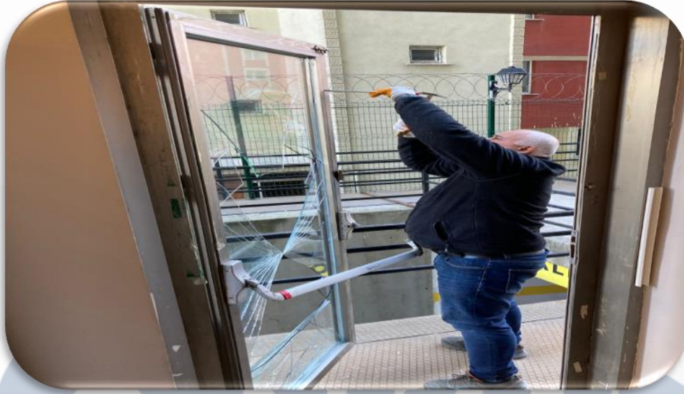
A Blok yük asansörü lobi kat çıkışındaki kırılan kapı camı yenisi ile değiştirilmiştir.
