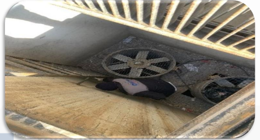
-4 Kapalı otopark katında bulunan aksiyel fan alanı temizlenmiştir.
