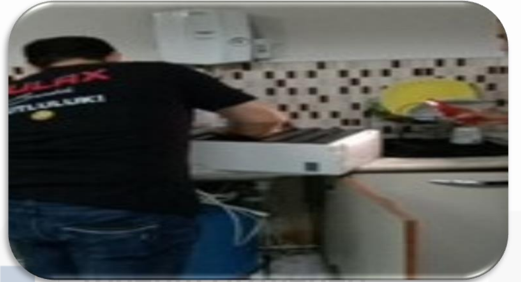
İçme suyu arıtma cihazının periyodik filtre değişimi gerçekleştirilmiştir.
