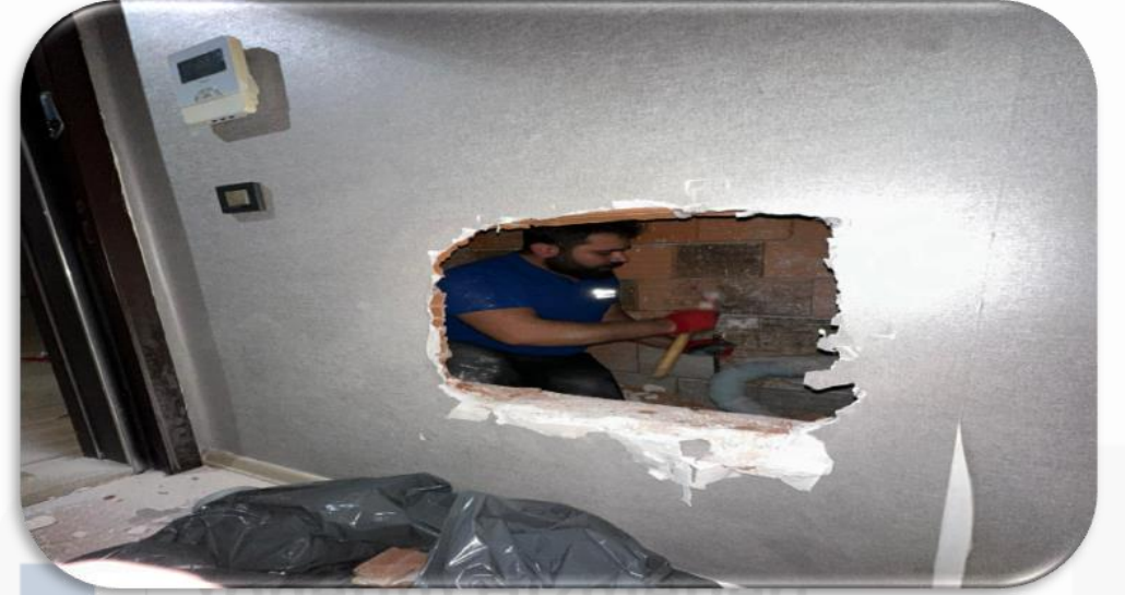
3-4 kat aralığındaki şaft su kaçağına teknik müdahalede bulunulmuştur.
