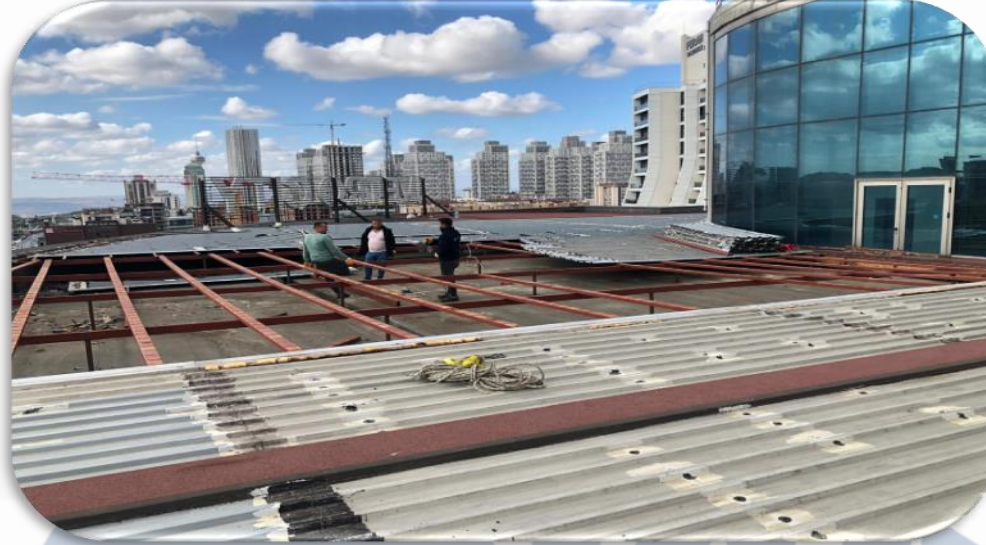
Çatı izolasyon çalışma planlaması kapsamında çatıdaki saç levha ve profil sökme işlemleri tamamlanmış ve vinç ile dışarı çıkartılmıştır.
