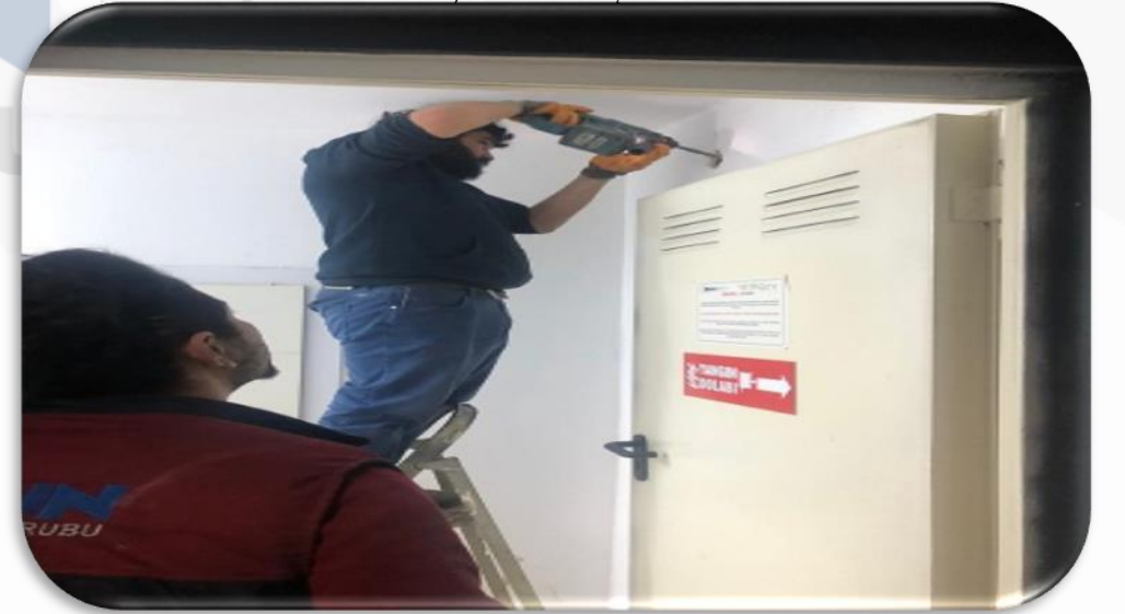
Elektrik odalarına otomatik söndürme sistemi ile kurulmuştur.
