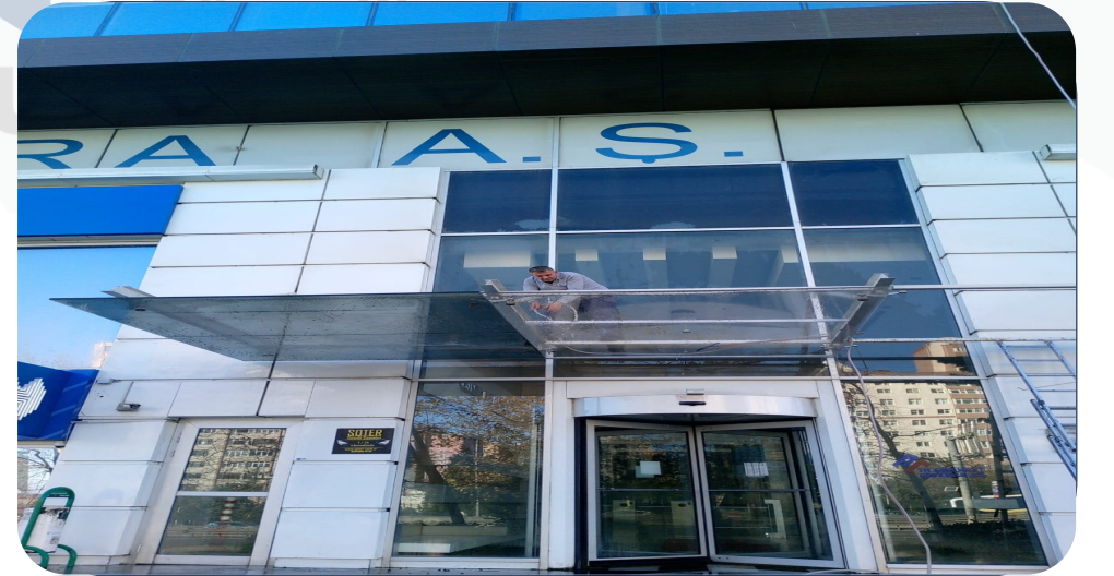
Küpeşte camlar temizlenmiştir.
