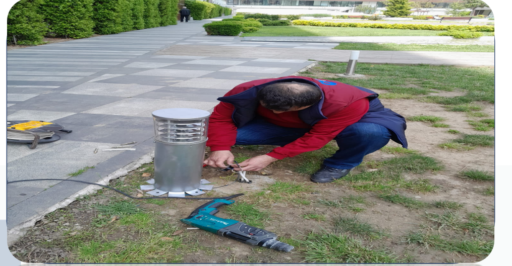
Bahe aydınlatmalarının retimi ve montajı yapıldı.
