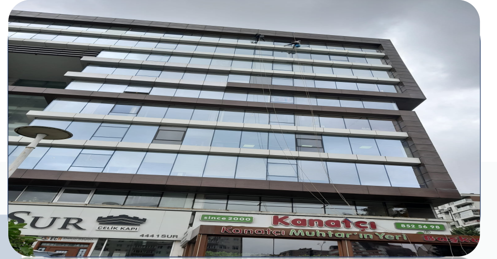
Dış cephe temizleme
