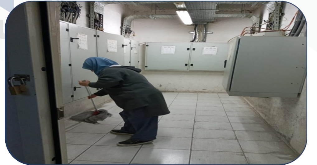
Elektrik ve Mekanik odalar temizlenmiştir.
