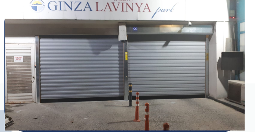
Otoparka Sarmal Kapı takılmıştır.
