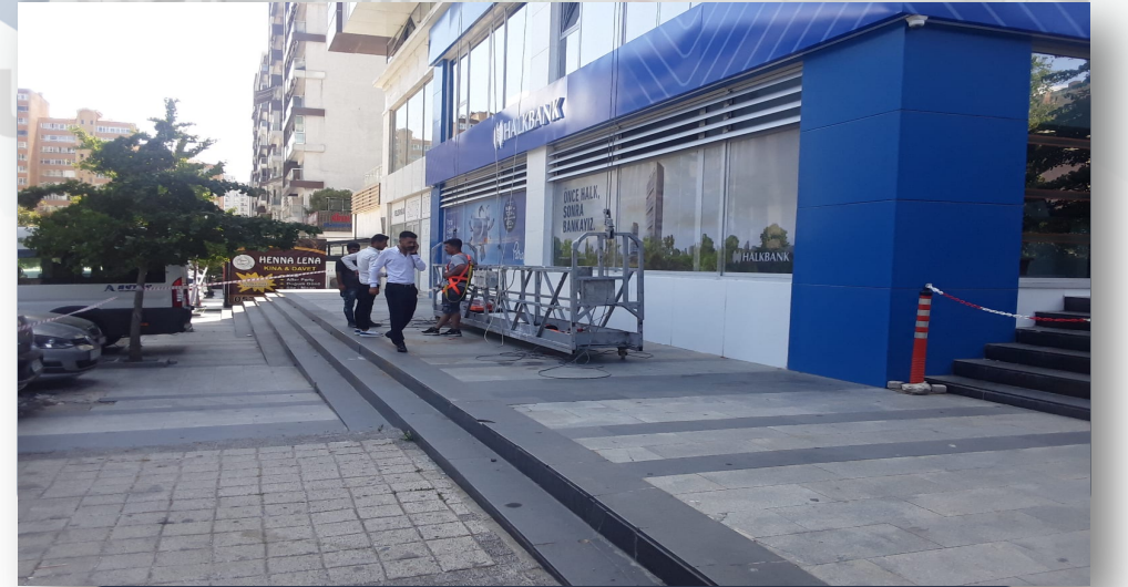
Dış Cephe kompozit onarımı
