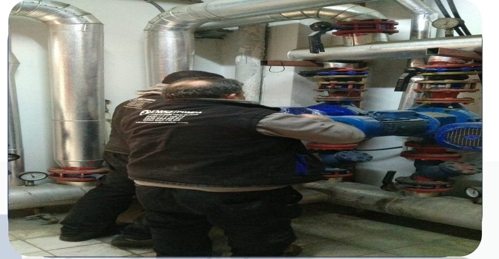
Emse Sızdırmaz Pompalarımızın onarımını yapmıştır.
