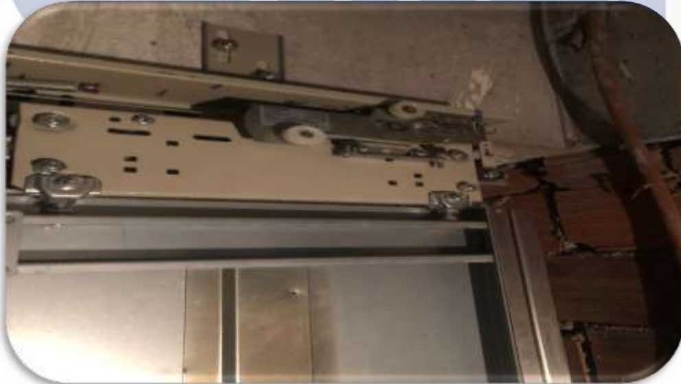
A blok yۆk asansۆrünün makastan ıkması ۆzerine gerekli teknik mۆdahalede bulunulmuřtur.
