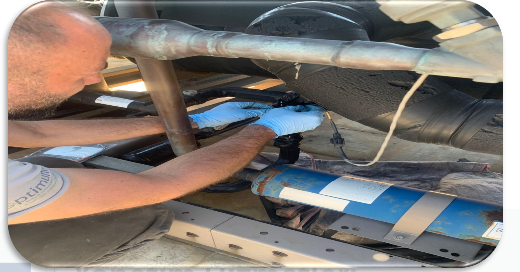
Soğutma Sistemi B Blok sistem 1 in edictör Gayrimanent sensörü deęiřtirilmiřtir.
