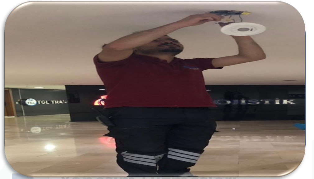
Bina geneli aydınlatma kontrolleri sağlanmış , arızalı aydınlatmalar yenileri ile değiştirilmiştir.
