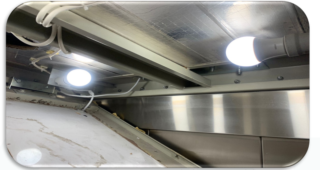
B Blok yük asansörü aydınlatması yenisi değiştirilmiştir.
