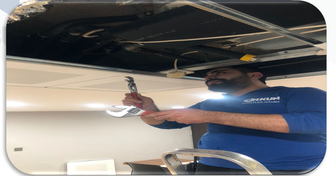
Bağımsız bölümlerin teknik servis talepleri karşılanmıştır.
