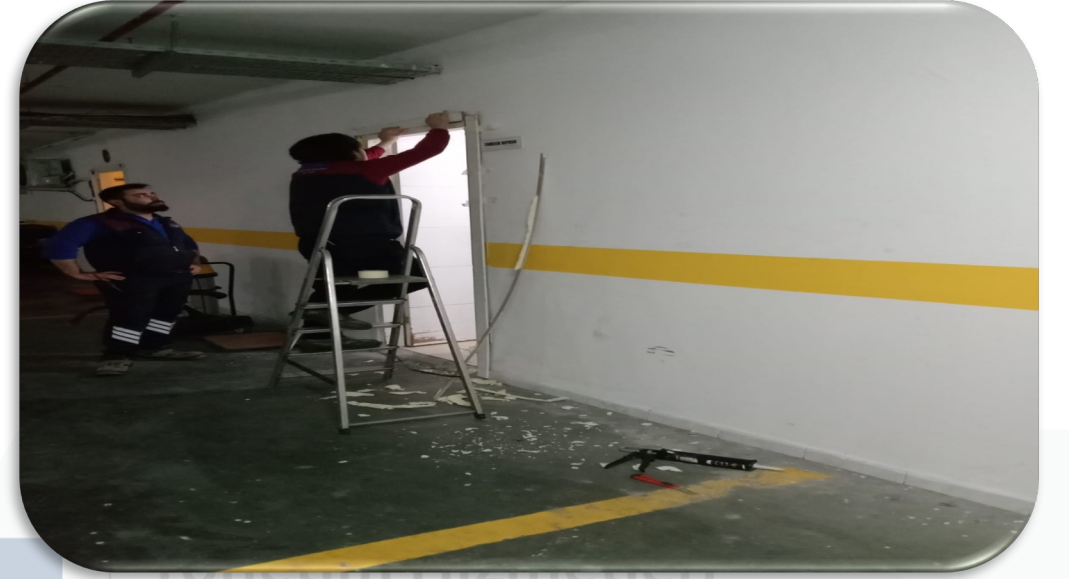
Teknik ofis ve temizlik deposu kapılarının çerçeveleri yenilenmiştir.
