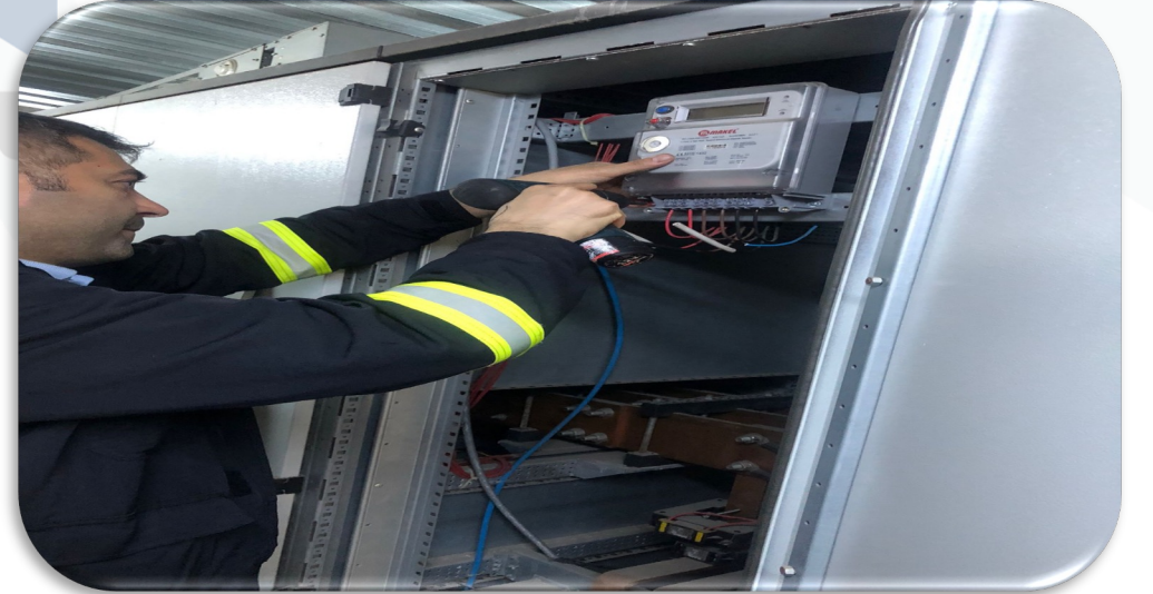
Ortak alan elektrik sayacı yenileri ile değiştirilmiştir.
