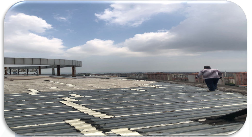
Çatı izolasyon keşif incelemeleri gerçekleştirilmiştir.
