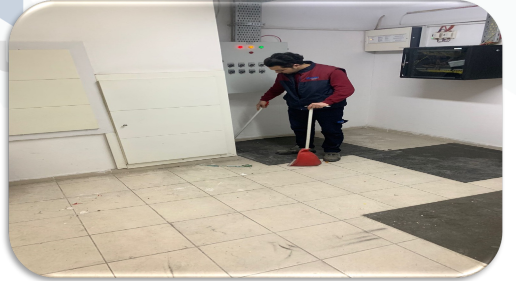
Elektrik odalarının temizliği gerçekleştirilmektedir.
