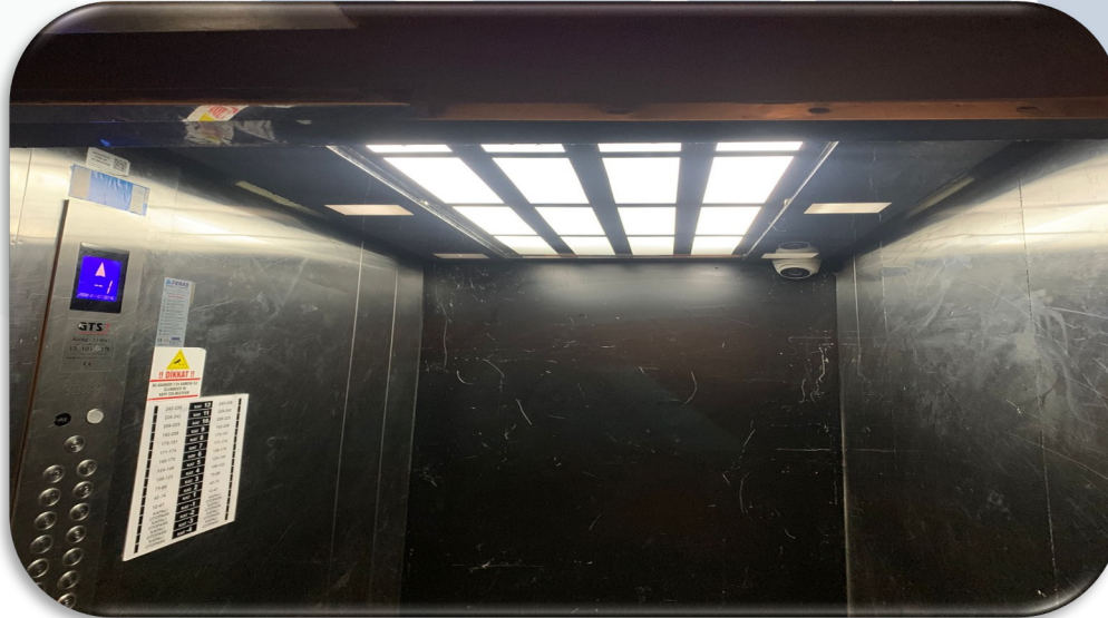
Asansörlerin kabin içi aydınlatmaları değiştirilmiştir.
