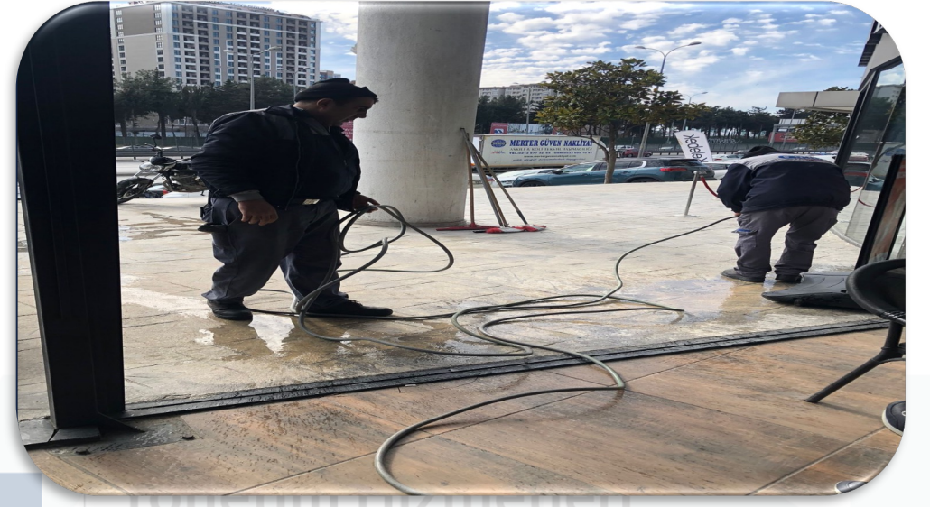
Bina girişleri yıkanarak temizlenmektedir.
