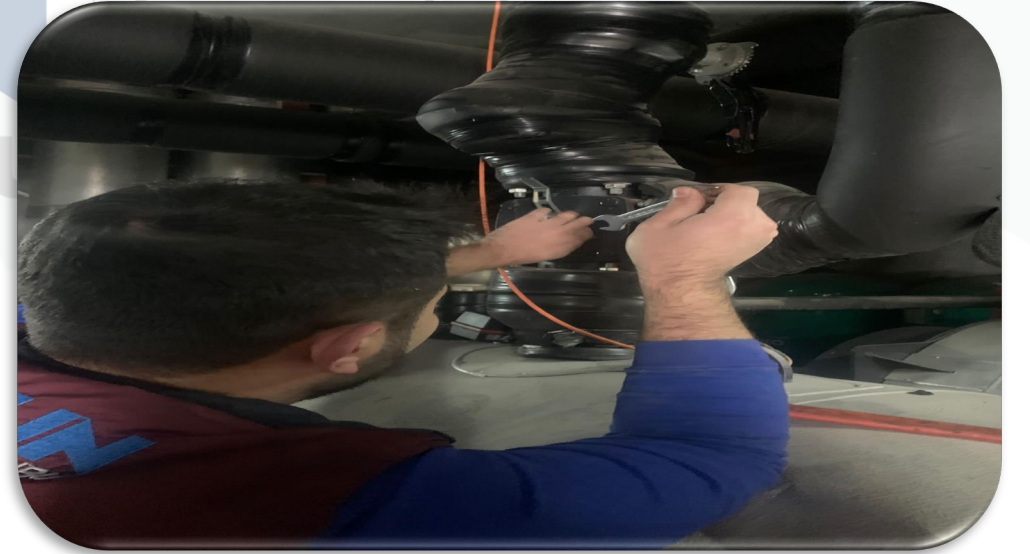
Bağımsız bölümlerin süzme sayaç kontrolleri gerçekleştirilmektedir.
