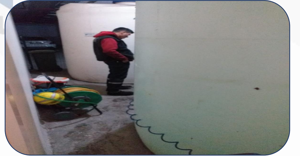
G Blok Hidrofor Havasının Tamamlanması
