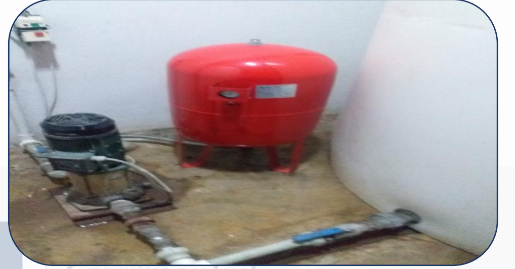
F Blok Genleşme Tankı Değişimi
