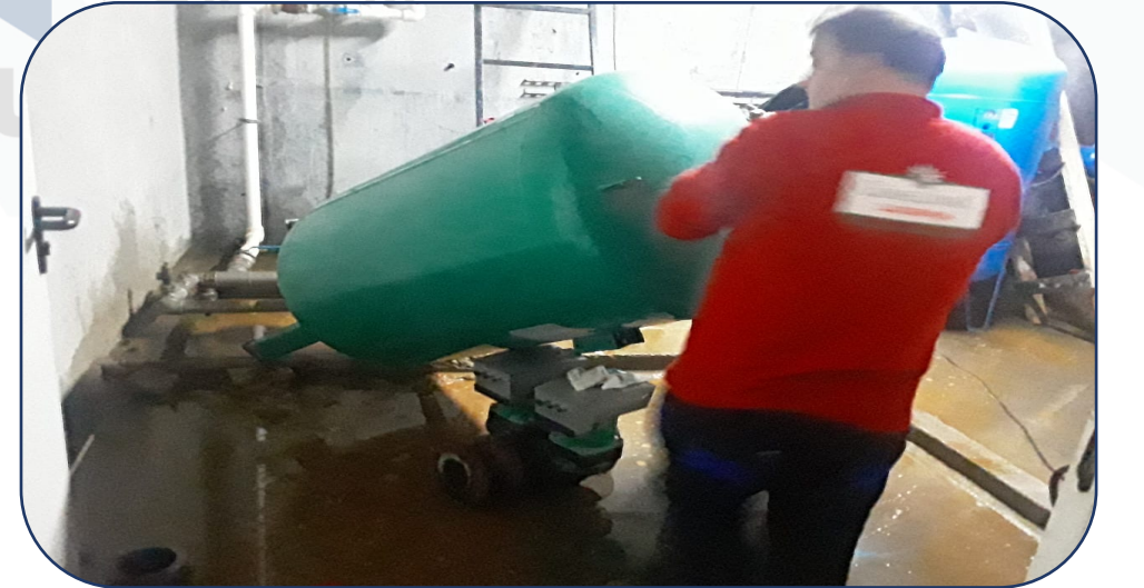
Tüm hidroforların basınç tankı membranları değiştirilmiştir.
