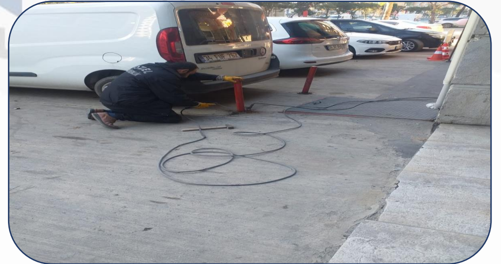
Dubaların Kaynatılması İşlemi
