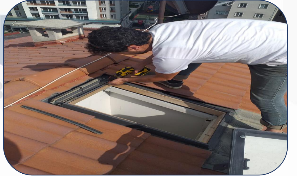
E blok çatı kapağı
