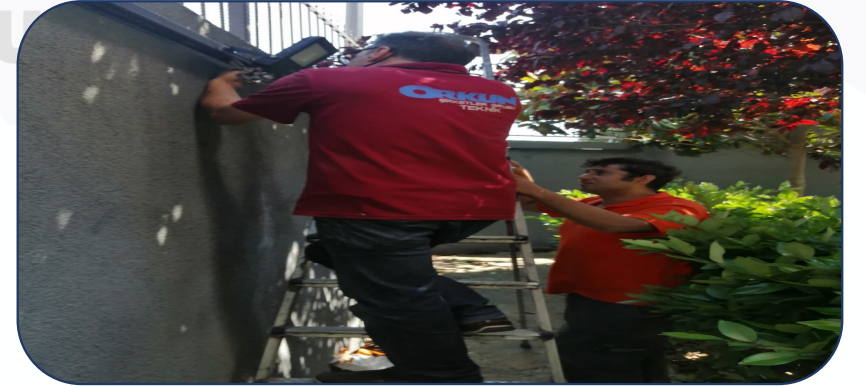
Arızalı aydınlatmalar değiştirilmiştir.
