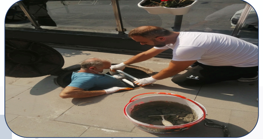
C-07 dükkan önündeki gider logar onarımı yapılmıştır.
