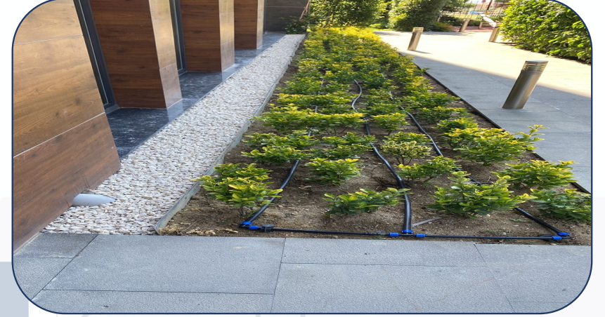
İhtiyaç olan yerlerin sulama sistemi yenilenmiştir.
