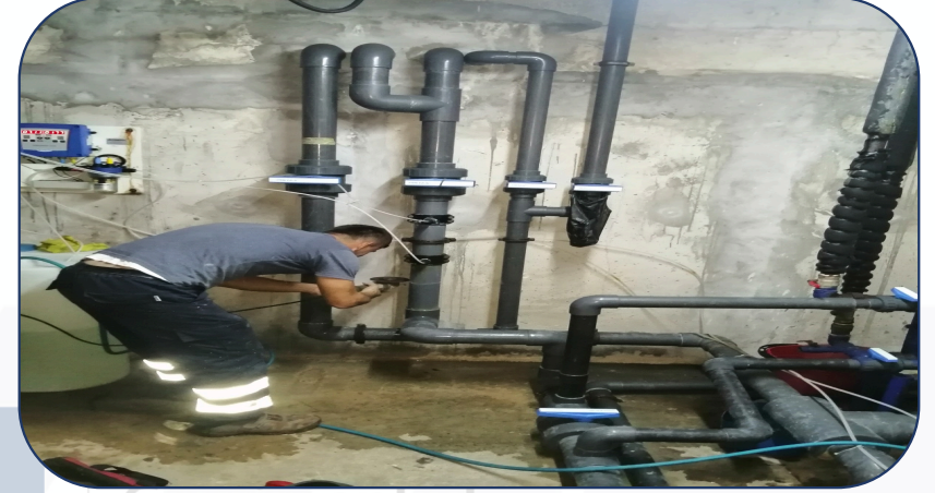
Havuz makine odasına pvc çekvalf takıldı.
