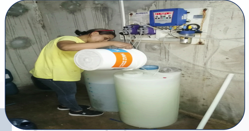
Hydrokim firması tarafından havuz bakımı yapılmaktadır.
