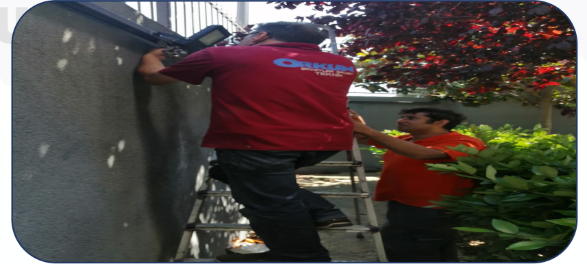
Arızalı aydınlatmalar değiştirilmiştir.
