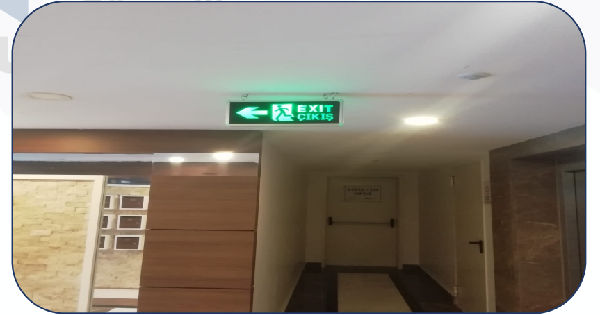
Arızalı çıkış levhası değiştirilmiştir.
