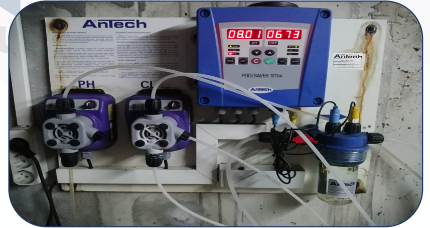
Dozajlama ünitesi onarılmıştır.
