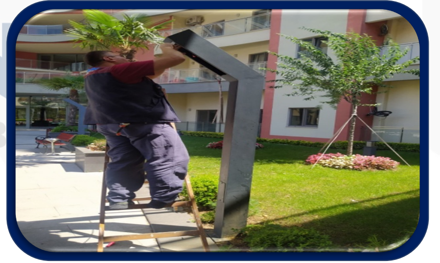
Ortak alandaki lambaların kontrolleri yapılmış, yanmayan lambalar değiştirilmiştir.
