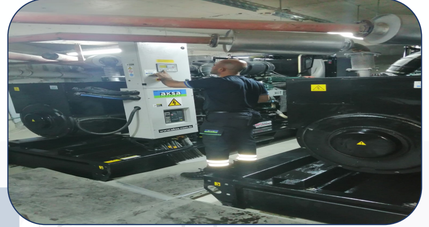
2 adet Aksa jeneratörümüzün 3 aylık bakımı yapılmıştır. .
