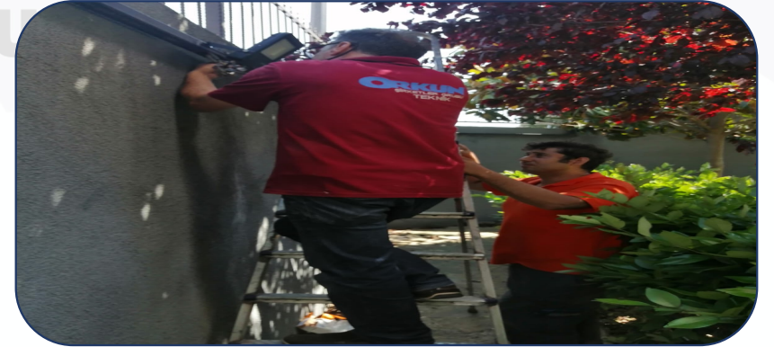
Arızalı aydınlatmalar değiştirilmiştir.
