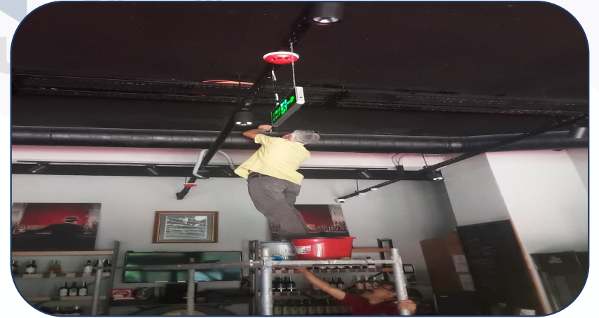
B-02 ve C-05 ortak alan tesisat arızaları onarılmıştır.
