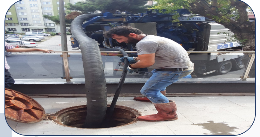
Araç ile kanal temizleme yapılmıştır..
