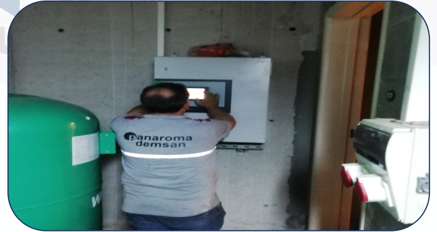
Emse Sızdırmazlık Pompa tarafından pompaların kontrolleri yapılmış, basınç ayarı yapılmıştır.
