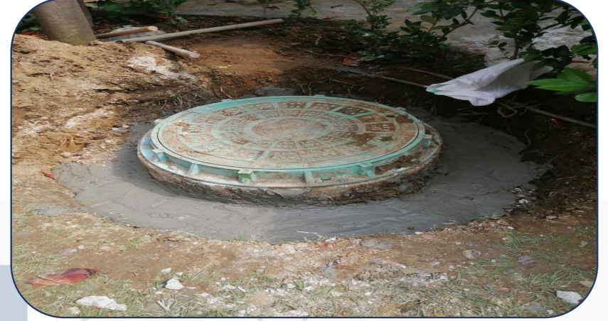
Bahçedeki logar onarılmıştır..
