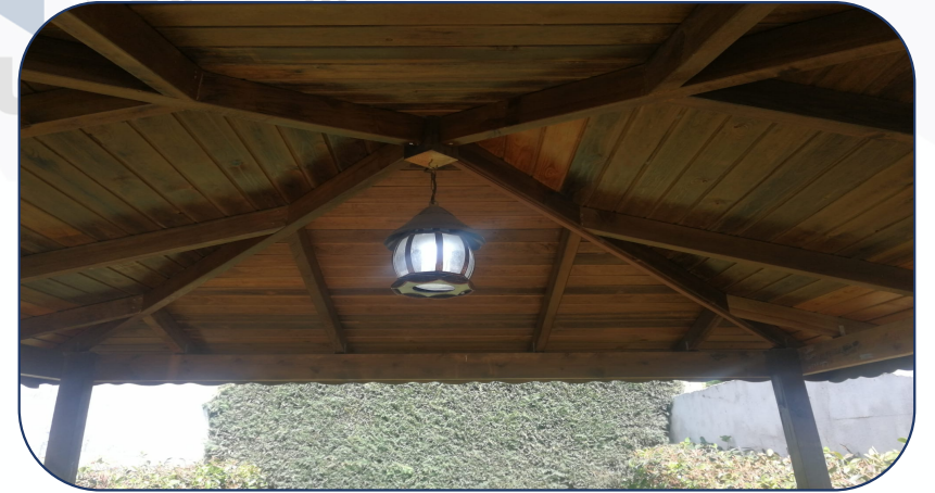
G blok önü çardak aydınlatması onarılmıştır.
