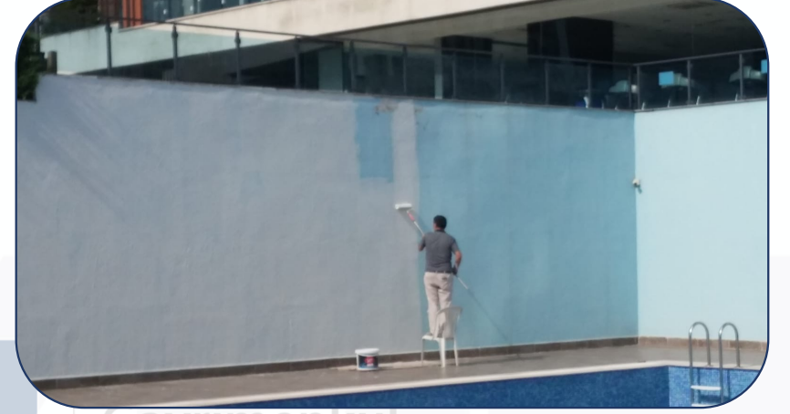
Açık havuz duvarları boyatılmıştır.
