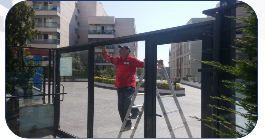
Açık havuz giriş kapısı boyanmıştır.
