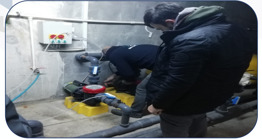
Diđer havuz pompası da onarıma gitmiřtir.
