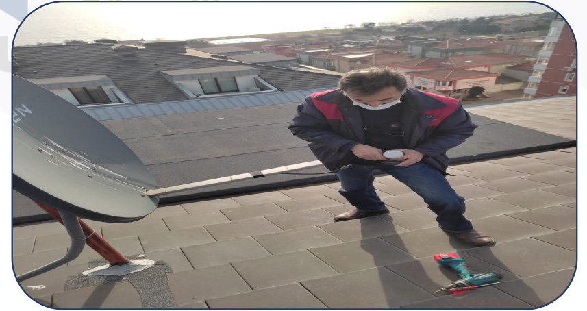
Arızalı LNB'ler değiştirilmiştir.
