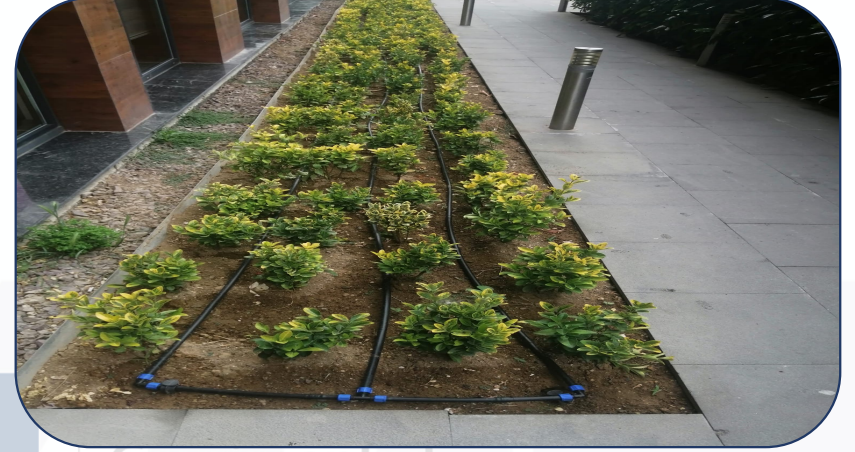
İhtiyaç olan yerlerin sulama sistemi yenilenmiştir.
