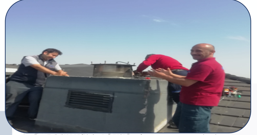
D Blok mutfak havalandırma fanı onarımı yaptırılarak yerine takılmıştır...
