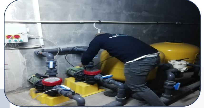
Diđer havuz pompası da onarıma gitmiřtir.
