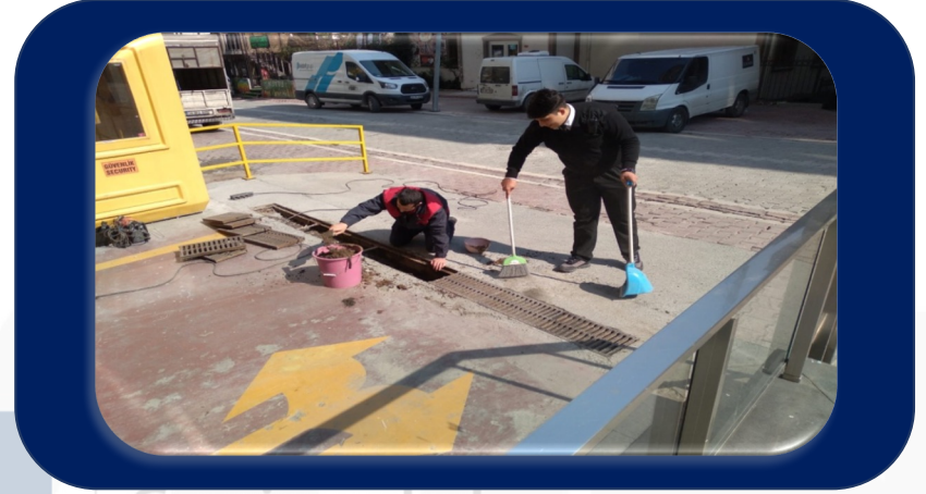
Otopark girişindeki mazgallar olası hırsızlıklara karşı kaynak yapılarak sabitleştirilmiş ve içi temizlenmiştir.
