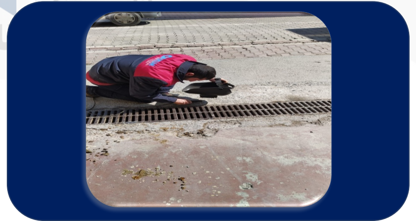
Otopark girişindeki mazgallar olası hırsızlıklara karşı kaynak yapılarak sabitleştirilmiş ve içi temizlenmiştir.
