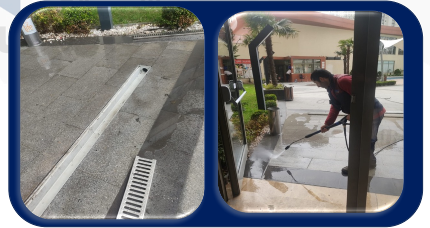
Giriş lobinin temizlenmesi
