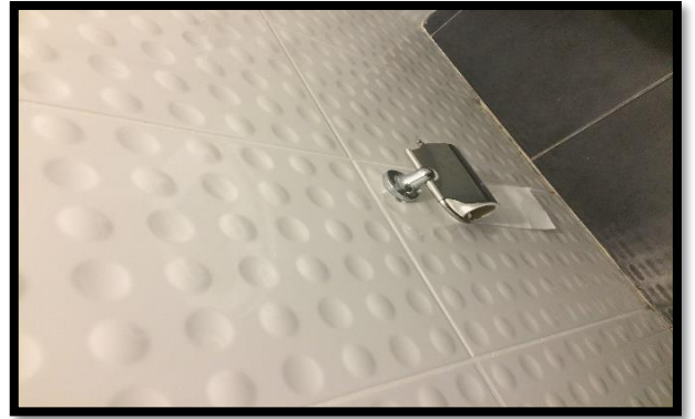
Hamam Wc'lerine kağıtlık montajı
