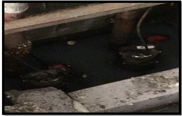
Pompalar ve seperatör duvarı
