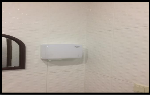
Wc lavabosuna z peçetelik montajı
