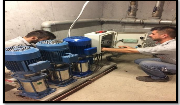
Hidrofor pompa montajı yapılmıştır.
