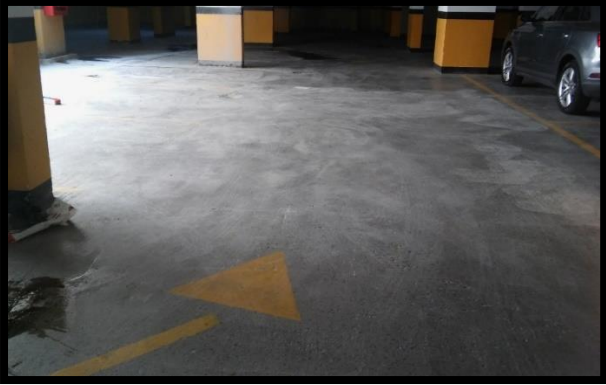
Kapalı otopark eski yapılmamış hali
